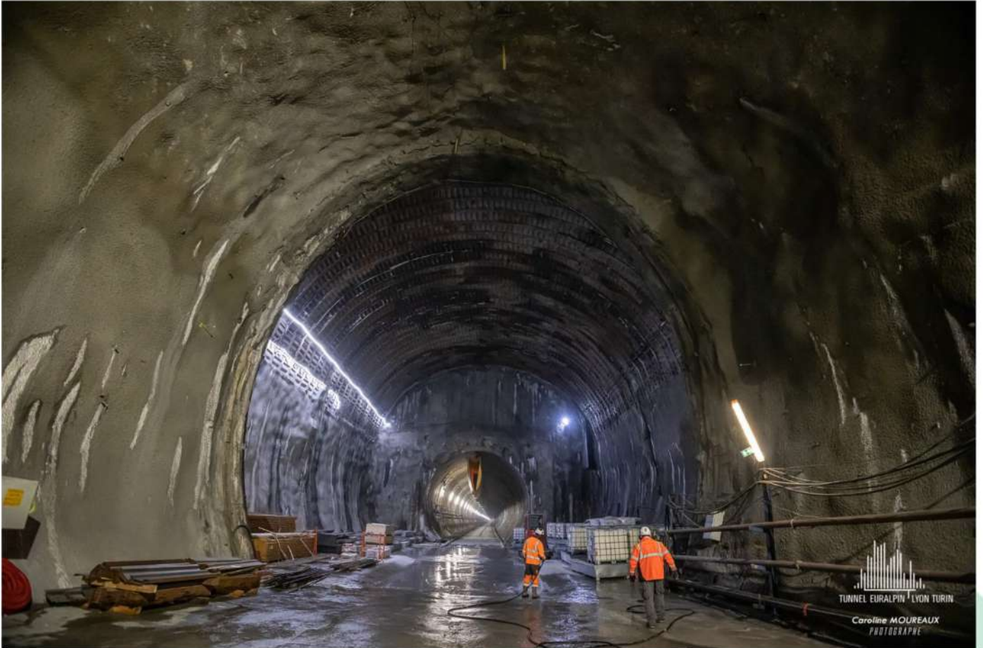
Chambre de démontage du tunnelier Federica – Pied de la descenderie de La Praz
